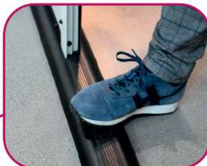
Soglia ribassata in acciaio sulla porta pedonale
